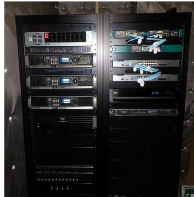
・改修したラック
